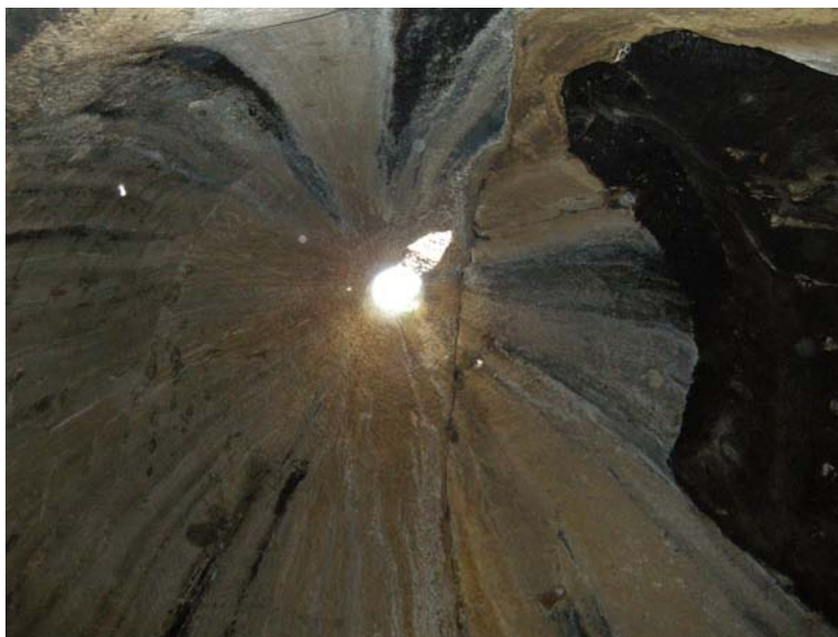
Fig. 4 La volta del vano a campana con foro superiore (da BRUNAZZI et alii 2017, p. 16)
